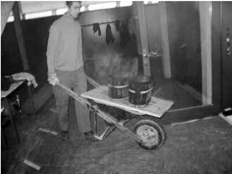
Pech und Schwefel – das Fundament des Uhrenmuseums
